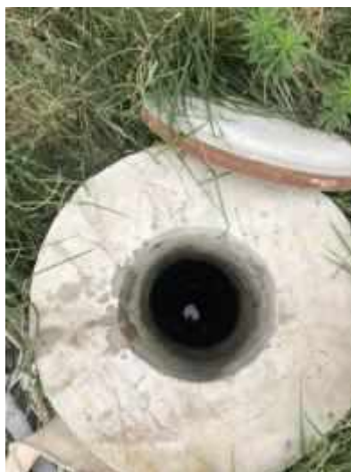
地下水监测井
